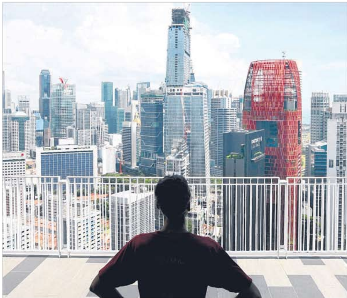
丹戎巴葛中心的主楼国浩大厦高290公尺，完工后将是本地最高的摩天大楼。（周柏荣摄）
